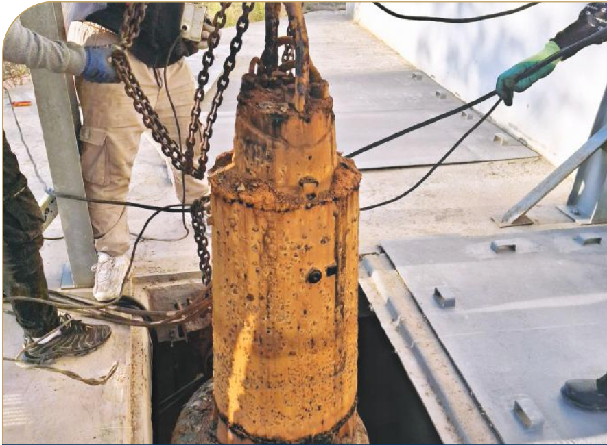
رفع المضخات المعطوبة قصد إخضاعها لأشغال الصيانة والإصلاح
